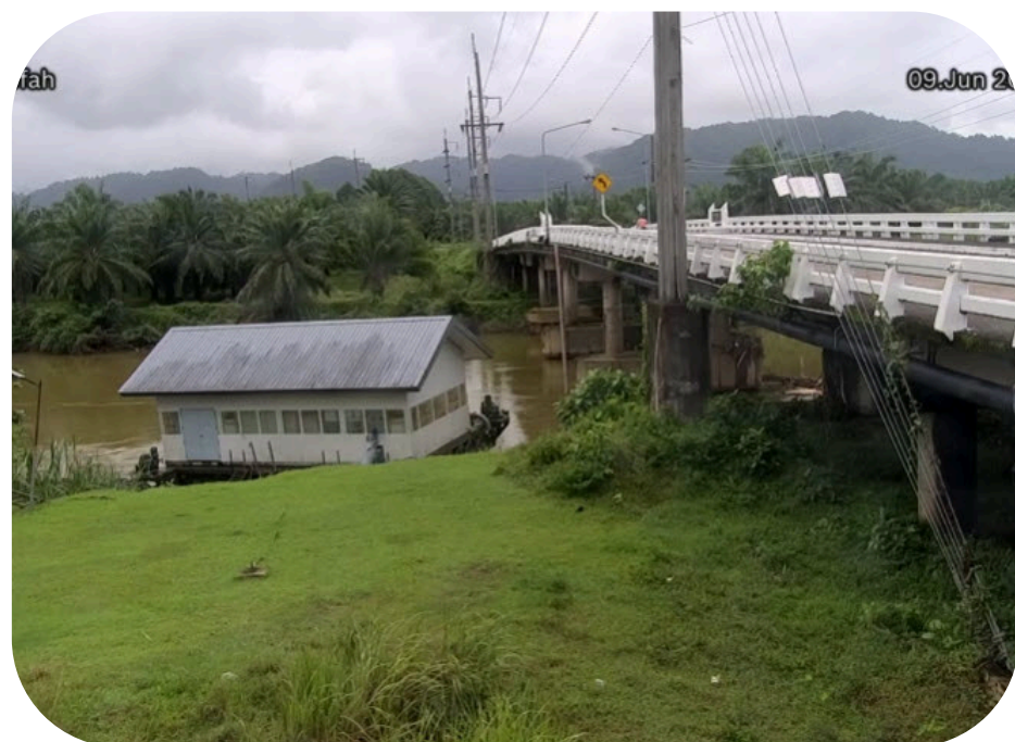
สะพานท่านเจ้าฟ้า อ.ตะกั่วป่า จ.พังงา
